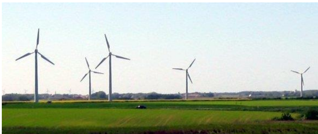
Fotografia 66. Turbinat e erës
